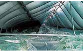
雪の重みでパイプが逆方向に曲がり、倒壊したビニールハウス(中野市)
