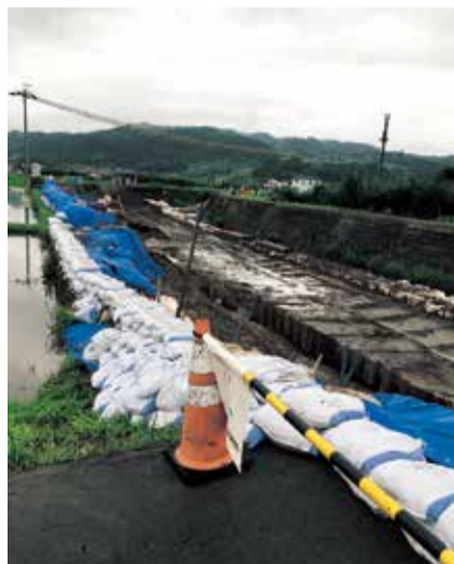
◀19号台風で欠損した岡田川堤防の工事個所で越水を防ぐ応急対策を求めました
