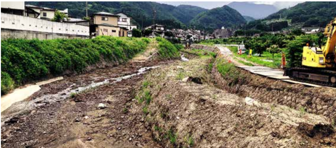
土砂などの撤去が完了した 檀田大橋から上流部分
