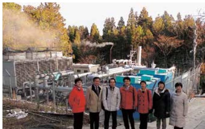
小規模な五湯苑地熱発電所 （2016年1月26日視察・大分県別府市）
