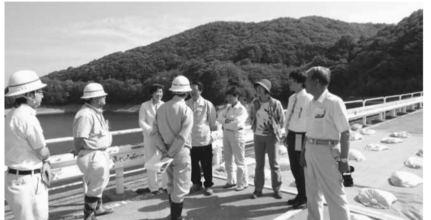
地震でヒビが入った福島県羽鳥ダムを視察（6月7日）
