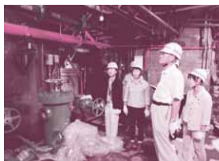
春近発電所の事故調査 (7月26日)
