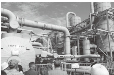
大分県の九州電力・八町原（はっちょうばら）発電所。出力11万kwの地熱発電で日本一の規模です。（5月25日）
